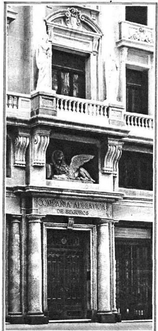
Detalle de la fachada.
